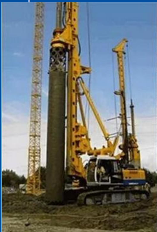
旋挖跟管钻进穿越
