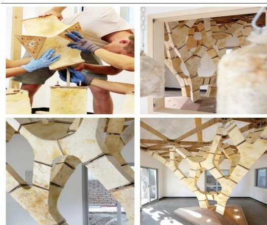
(b) MycoTree 菌丝体支撑结构
