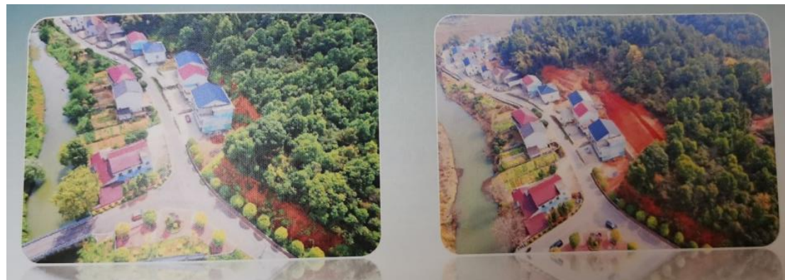
湖南浏阳焦溪镇“隐患点+风险区”微治理
