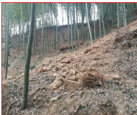
宜溧残坡积碎石土滑坡
